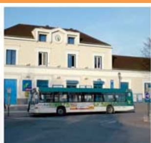
La gare de Montgeron-Crosne est en cours de réfection.
