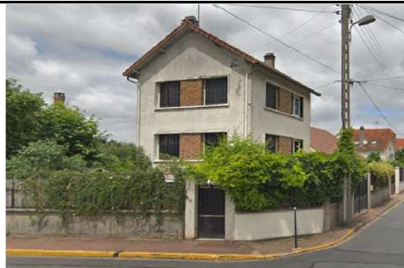
Avant renovation et isolation
