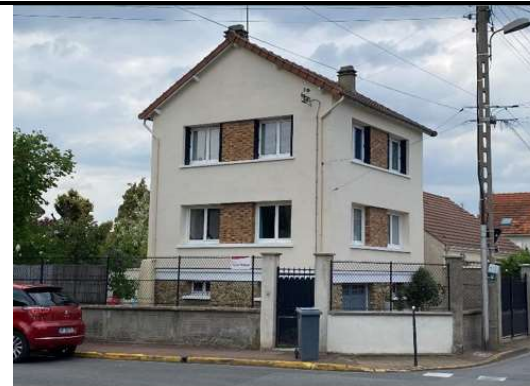
Après rénovation et isolation par l'extérieur. Les appuis filants des baies sont reconstitués. Le parement de brique est conservé
