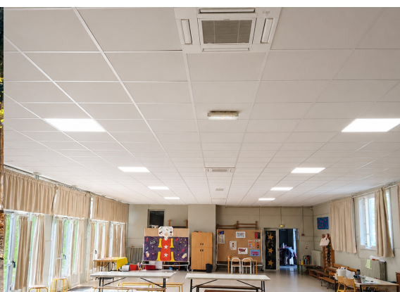
Installation d'une climatisation dans la salle de motricité, école F. Buisson maternelle
